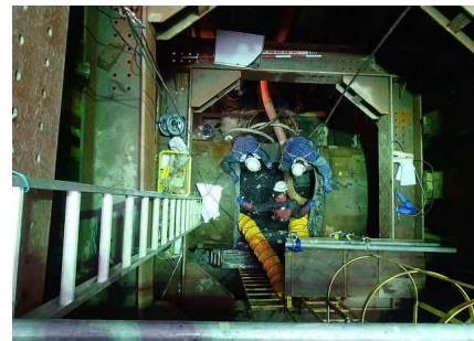
汚泥の引き抜き状況。
